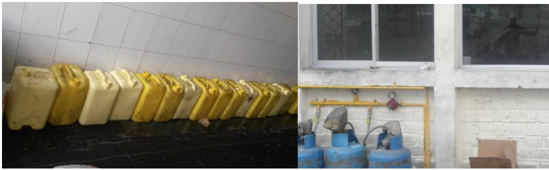
Figura 60 Almacenamiento de residuos de aceite comestible - Cilindros de gas sin señalización y sin almacenamiento adecuado
