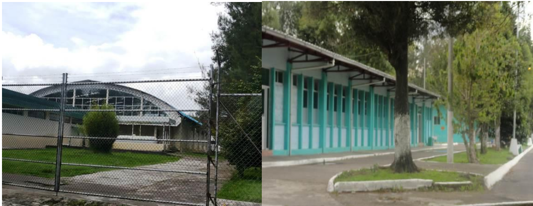
Figura 48 Piscina y sitio de almacenamiento de gas y habitaciones
