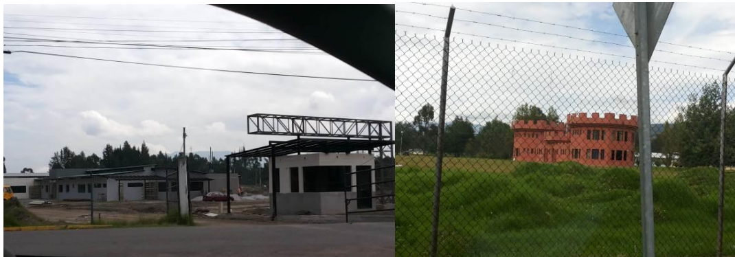
Figura 47 Comando Ductos y Refinerías y Edificio Cuerpo de Ingenieros
