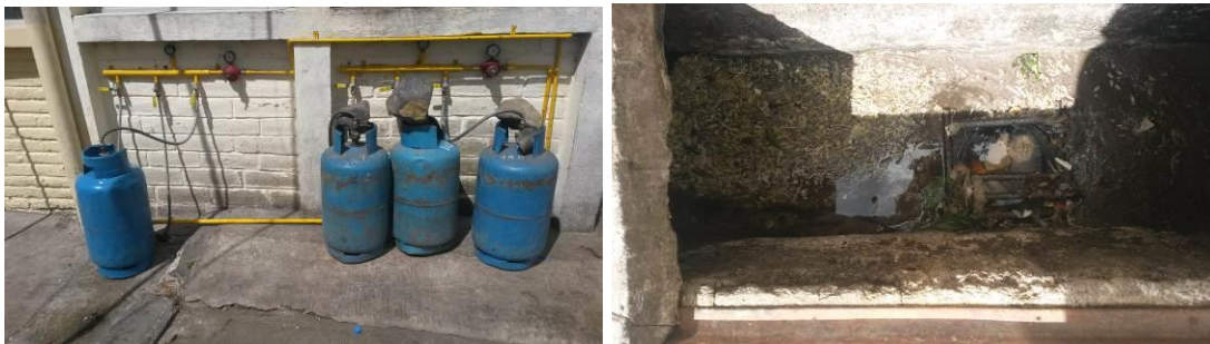
Figura 16 Almacenamiento de tanques de gas y canales
