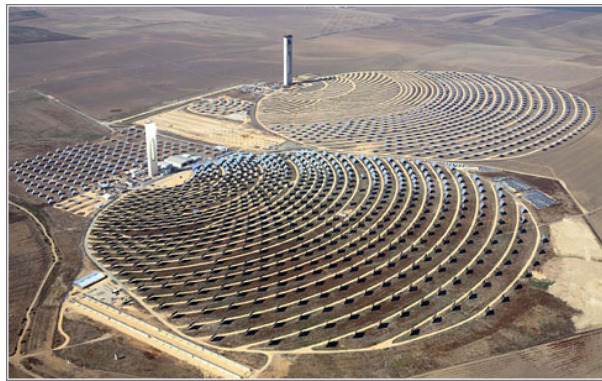
Figura 24. La PS10 primera planta solar térmica de torre a escala mundial de uso comercial
