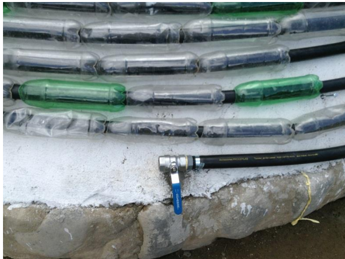
Figura 8 Calentador de tubos concéntricos con PET/polietileno
