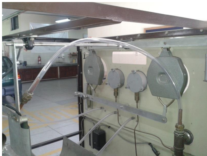
Figura 30 Manguera de \frac{1}{2} " para el paso de Combustible
