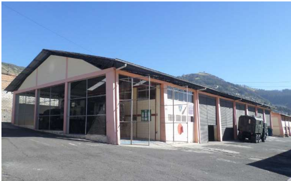
Figura 8. Instalaciones utilizadas para realizar mantenimiento
