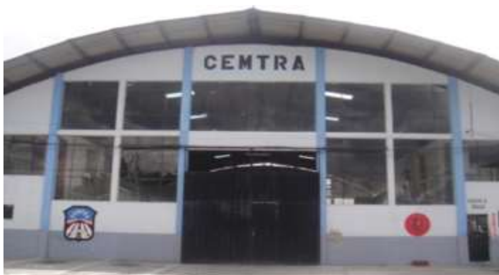
Figura 9. Centro de Mantenimiento de Transportes
