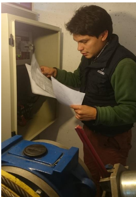
Figura 55. Conexión del cuadro electrónico mediante esquemas eléctricos
