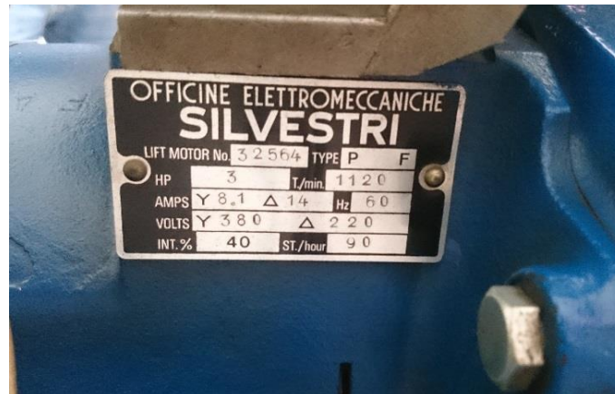
Figura 61. Placa de motor del ascensor
