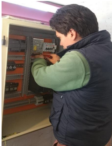
Figura 53. Conexionado del control electrónico
