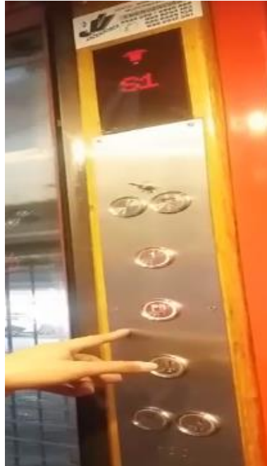
Figura 69. Prueba de señales luminosas dentro de la cabina del ascensor
