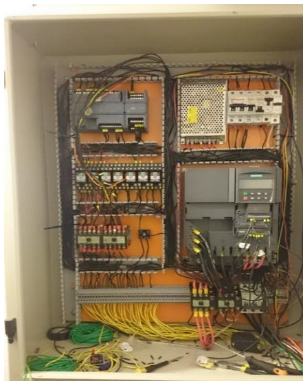
Figura 54. Etapa de conexión del control electrónico
