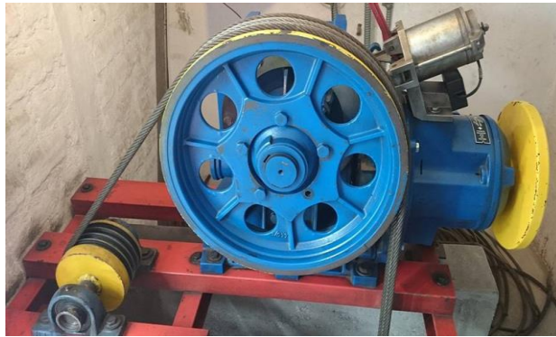
Figura 37. Máquina de tracción del ascensor de 3 plantas
