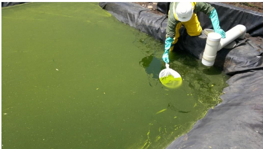
Figura 10. Recuperación de biomasa por flotación en la laguna de oxidación
