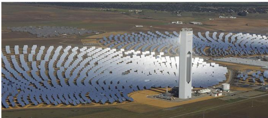
Figura 9: Torre para concentración solar.
