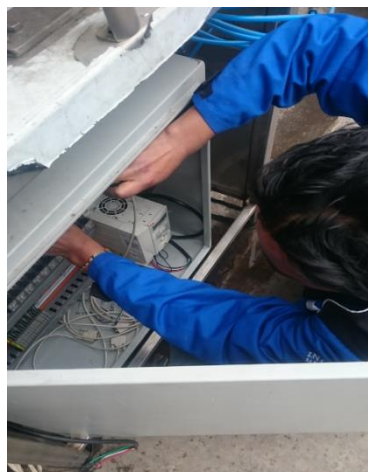
Figura 97. Montaje y distribución de los componentes eléctricos.
