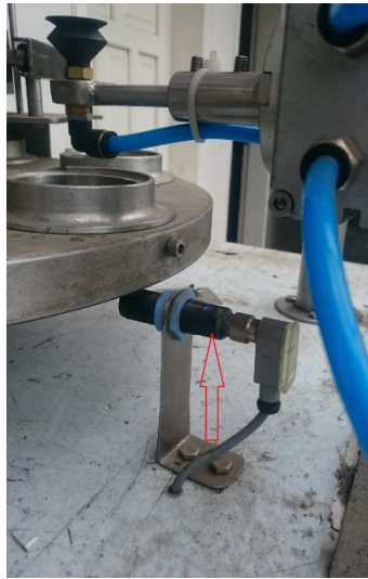
Figura 99. Montaje del sensor óptico.
