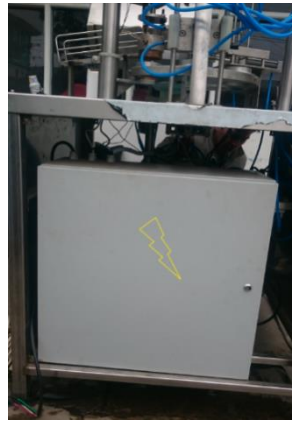
Figura 96. Montaje del tablero eléctrico.
