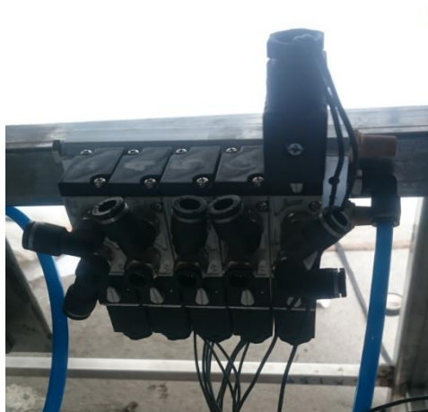
Figura 89. Montaje de las electroválvulas.
