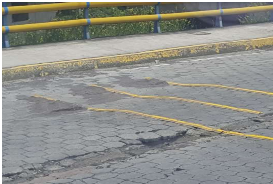
Figura 8. Puente vía Santa Rosa – entrada a Sangolquí
