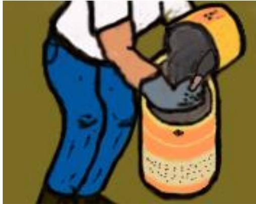
2. Se revuelve mínimo 3 minutos con taladro de bajas revoluciones (max. 500 rpm) para evitar al máximo la inclusión del aire, hasta obtener una mezcla homogénea.
