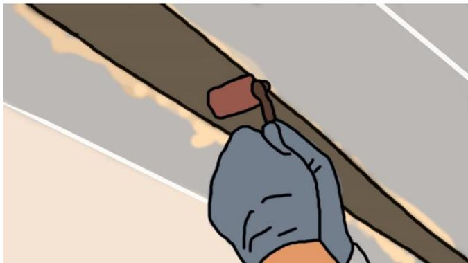
9. Finalmente, la superficie de la platina se puede recubrir con el revestimiento de protección para fines de acabado.
