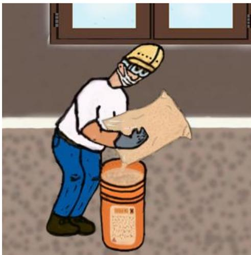
6. Realizar la mezcla hasta obtener una composición homogénea. Tiempo estimado de 3 minutos.
