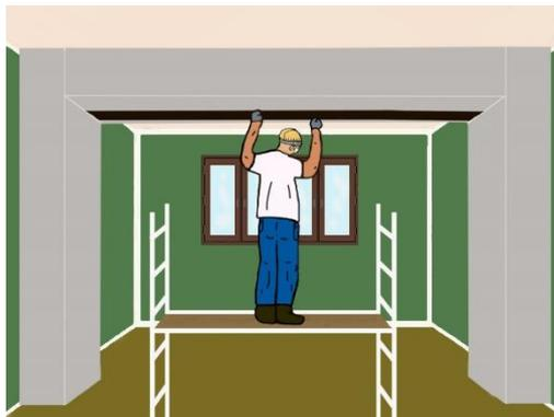
8. Con la ayuda de un rodillo, se presiona la platina sobre la masa del epóxico hasta que el adhesivo sea forzado a salir a ambos lados de la platina. Posteriormente se remueve el excedente de adhesivo epóxico
