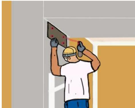
3. Con la ayuda de un taladro eléctrico realizar los orificios previamente marcados
