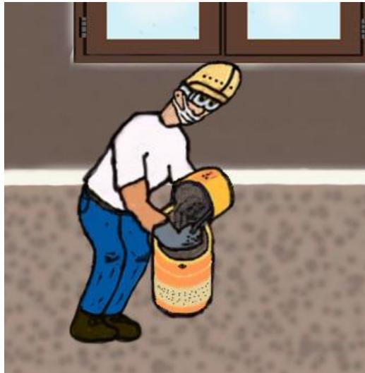
3. Resanar posibles fallas en la sección existente usando el epóxico estructural.
