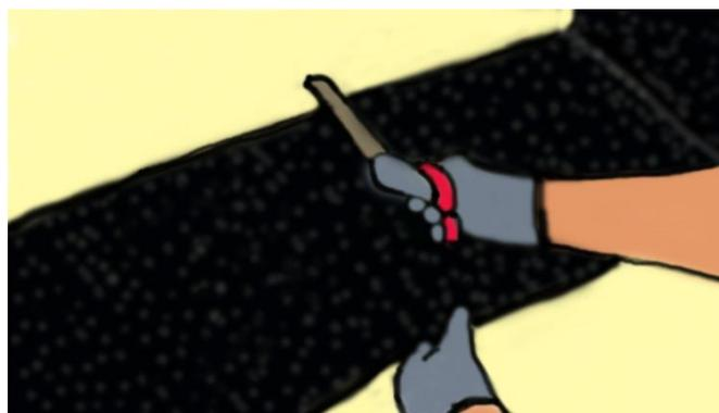
11. Mezclar los componentes de la resina epóxica adhesiva, esta servirá para la adherencia del tejido CFRP.
