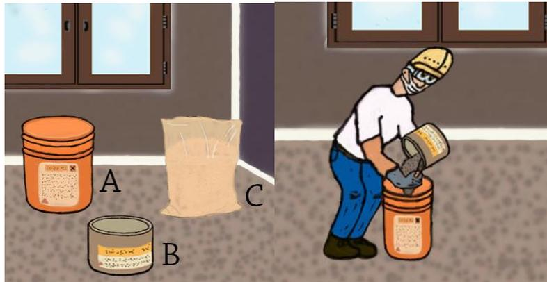
5. Incorporar el componente tercer componente del mortero de reparación.
