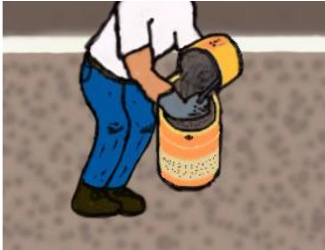
12. Batir los componentes hasta alcanzar una mezcla homogénea. Tiempo de 3 minutos como mínimo.
