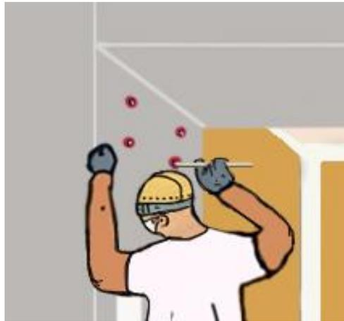
5. Rellenar los orificios con epóxico
