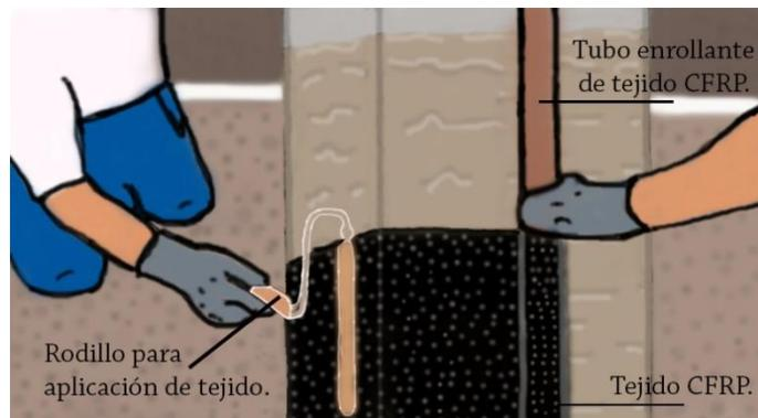
15. Pasar el rodillo para fijar el tejido de CFRP a la resina epóxica adhesiva. Esto se realiza para asegurar la correcta aplicación del refuerzo.
