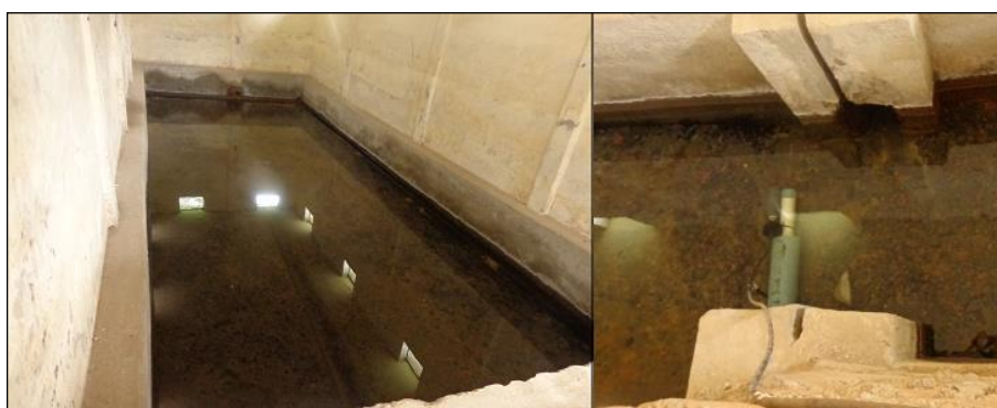
Figura 11. Estructura de la captación del flujo vertical
