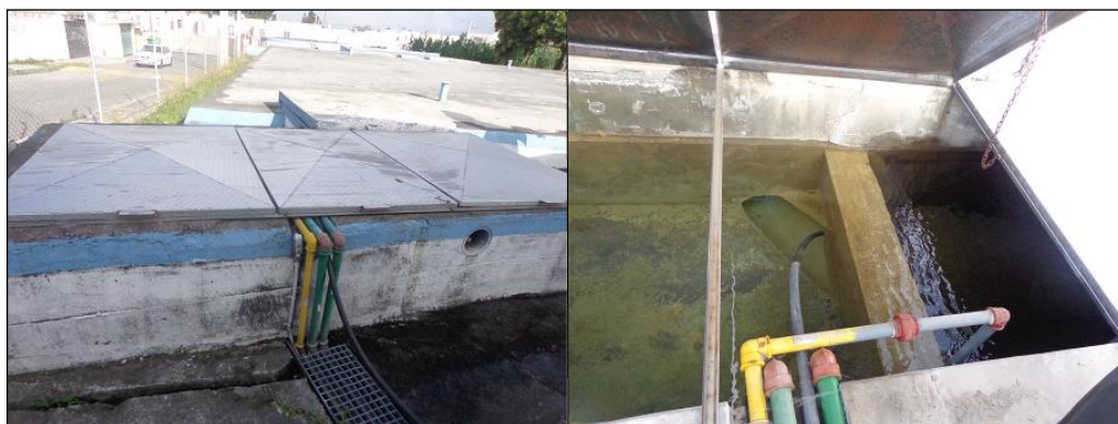
Figura 17. Vertedero de llegada al tanque Albornoz
