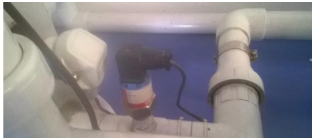
Figura 39 Transductor de presión de succión Cerabar
