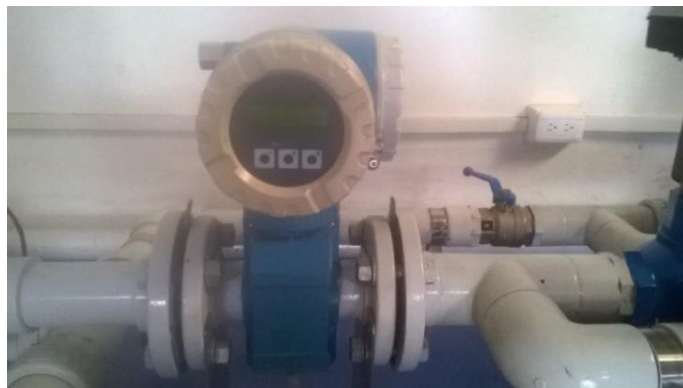
Figura 41 Medidor de Caudal Electromagnético
