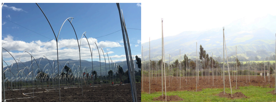
Figura 3. Construcción del Invernadero
