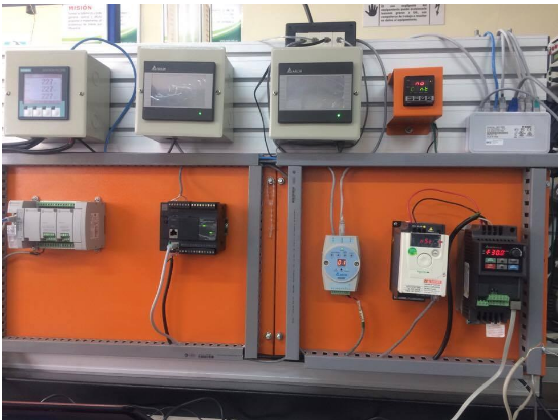
Figura 161 Montaje de los equipos de la red industrial Modbus
