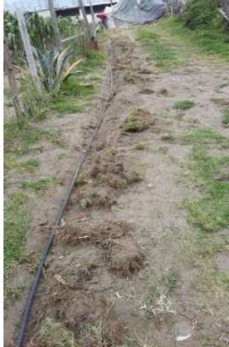
Figura 73: Soterramiento de cable
