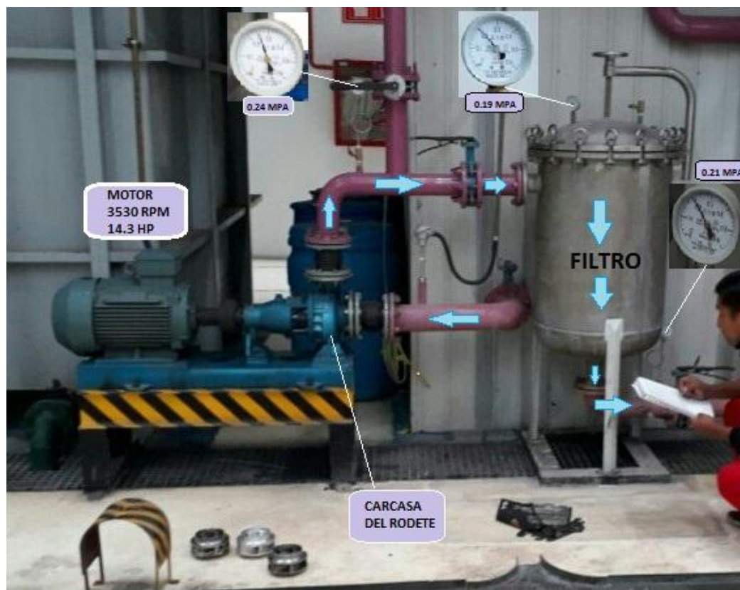
Figura 51 Circuito de flujo de bombeo.
