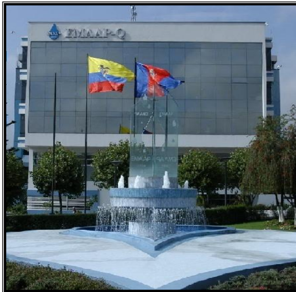
EDIFICIO MATRIZ (Bloque A)
