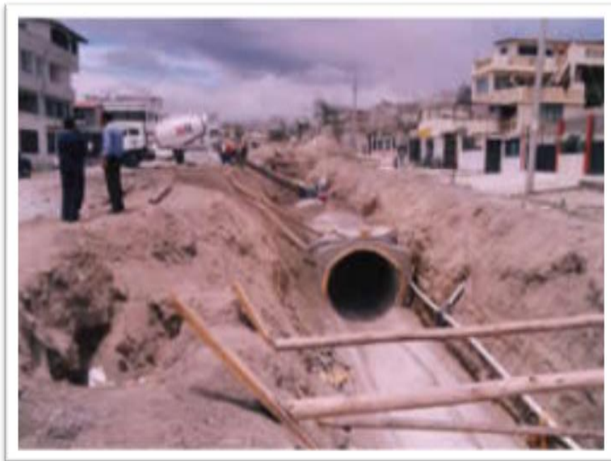
FOTO 3: Construcción de canal de Alcantarillado
