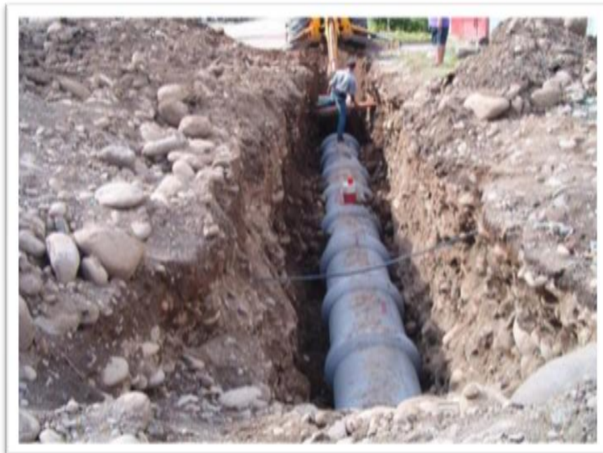
F O T O 5 : U b i c a c i ó n d e t u b o d e a l c a n t a r i l l a d o
