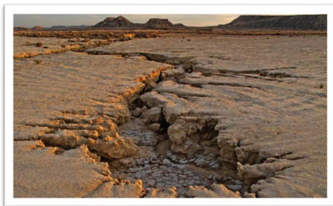
Figura 8: Erosión provocada por arranque de material
