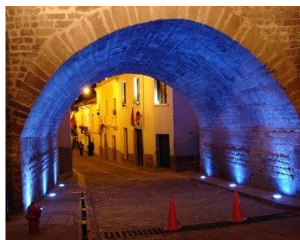
Figura 63 ‘‘puente de piedra’’
