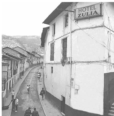
Figura 10 : Proceso de regeneración del Barrio la Ronda
