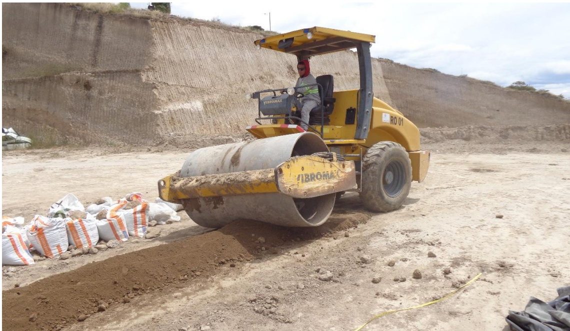
Figura 75 Aplicación de la energía de compactación
