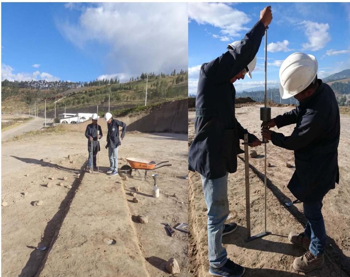
Figura 77 Control de compactación DCP,
