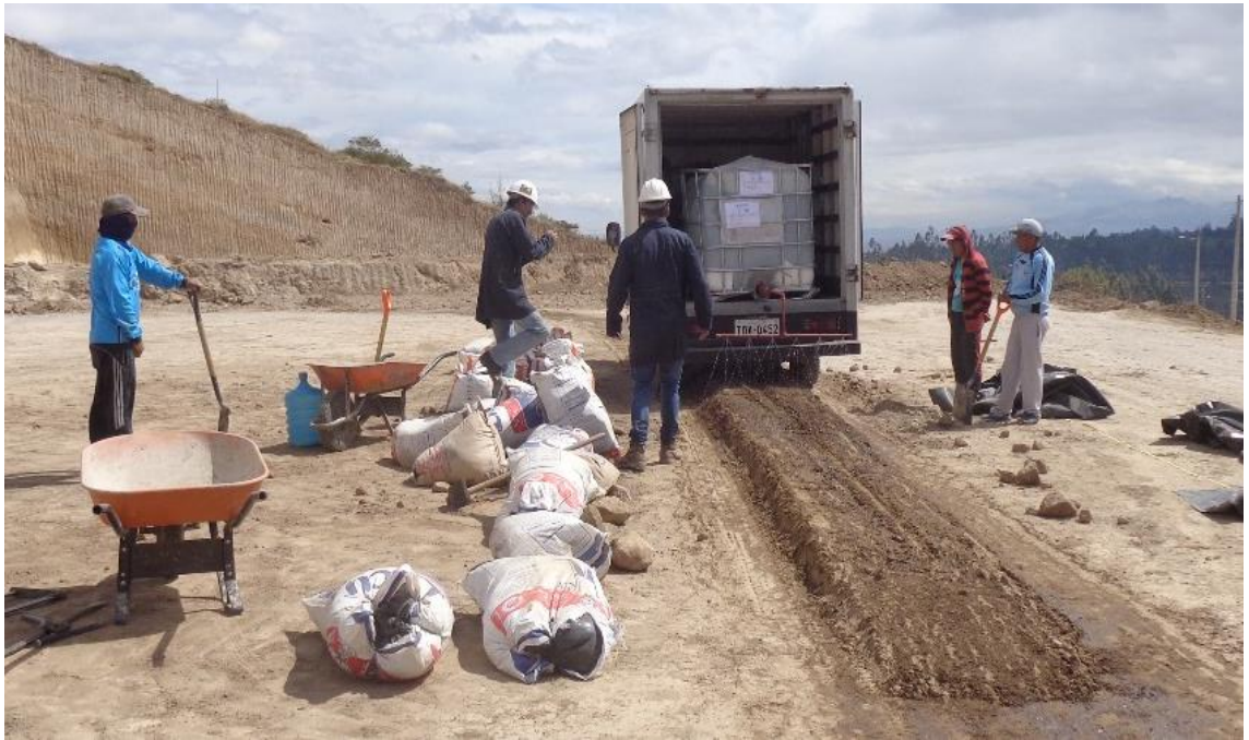
Figura 73 Hidratación del material
