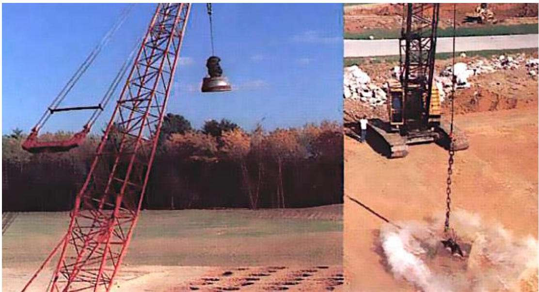
Figura 18 Efecto de la compactación por impacto
