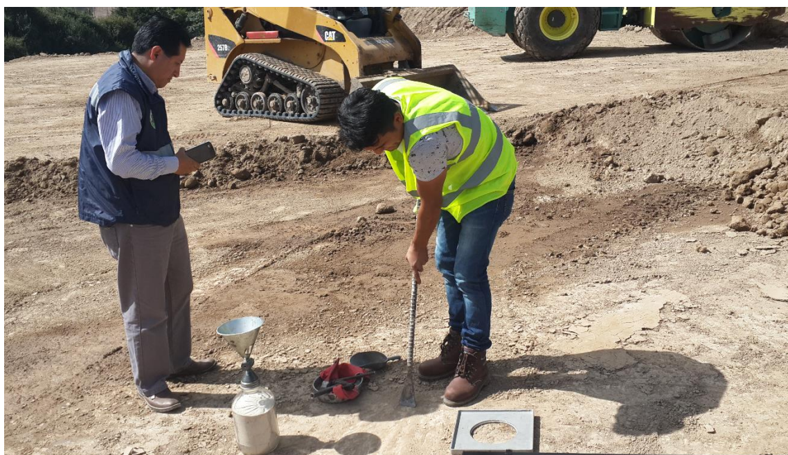
Figura 29 Aplicación del Cono y Arena en campo
