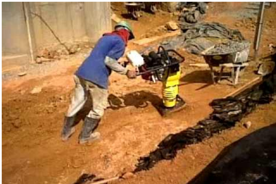
Figura 19 Apisonador en Obra
