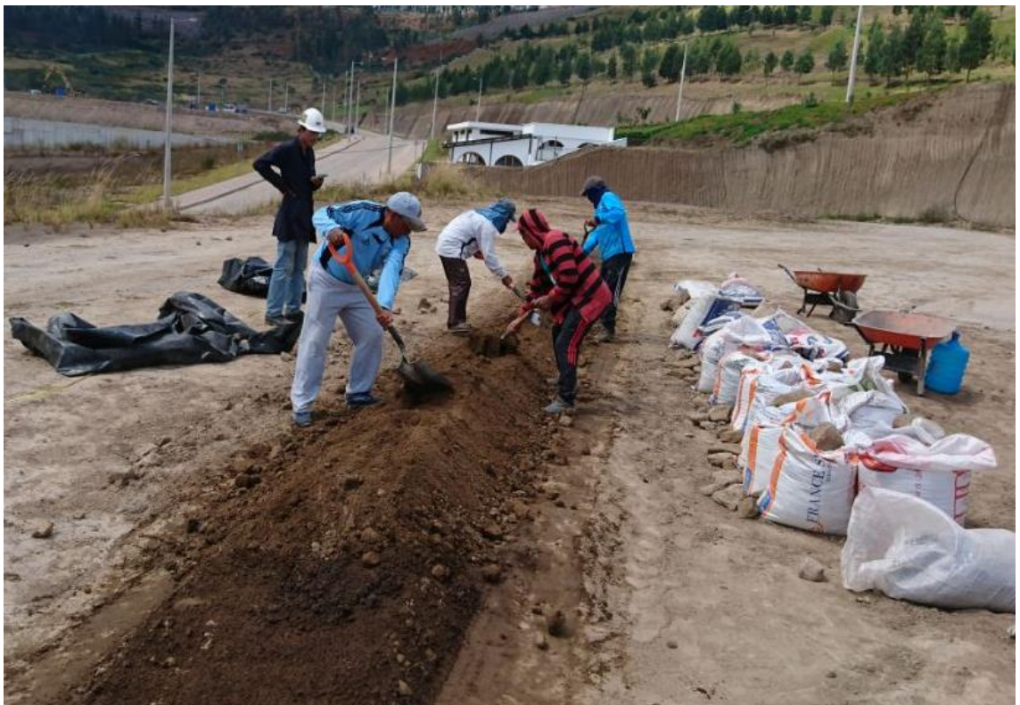
Figura 74 Homogenización del agua en el suelo
