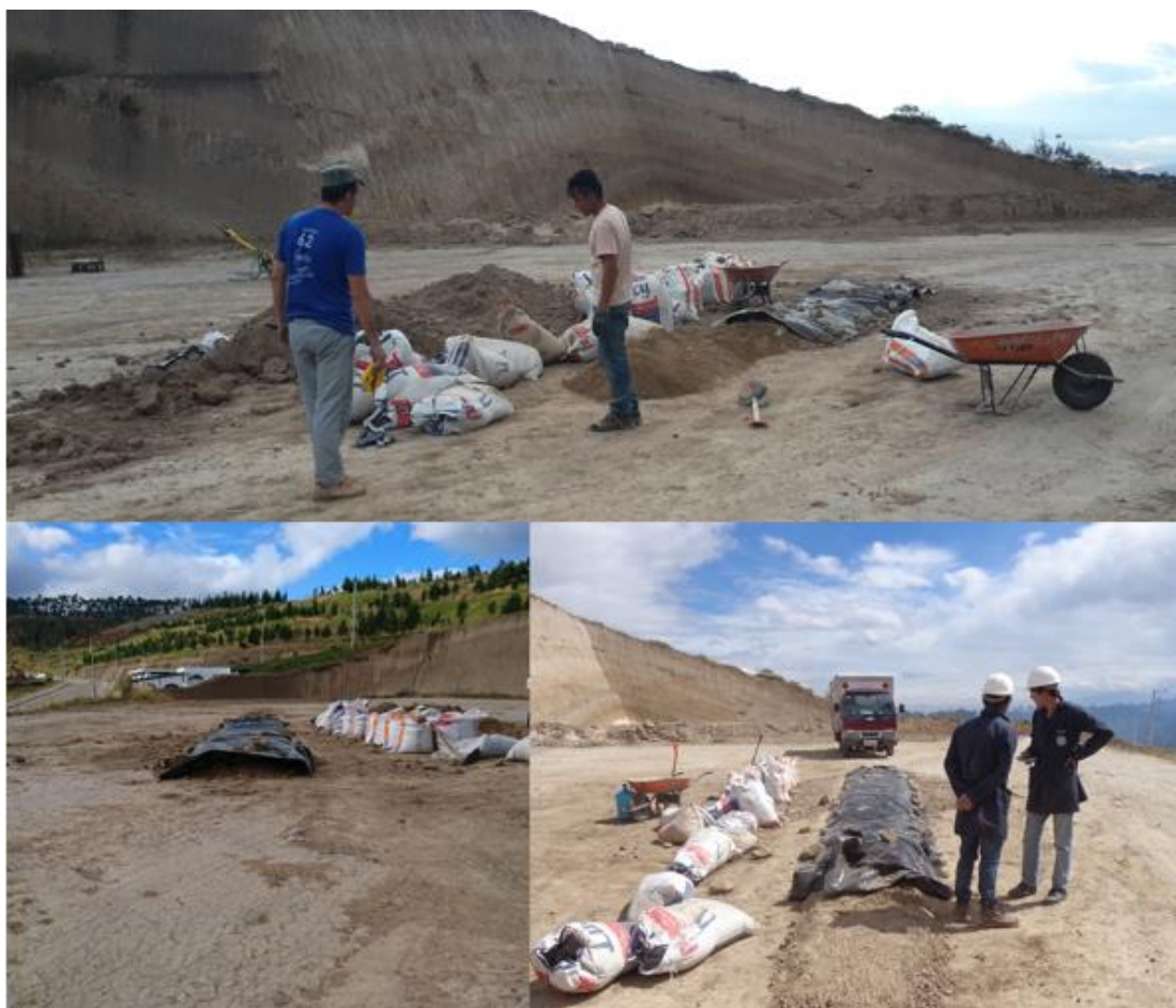
Figura 72 Tendido de los materiales ML (6 m) y SM (4 m)
