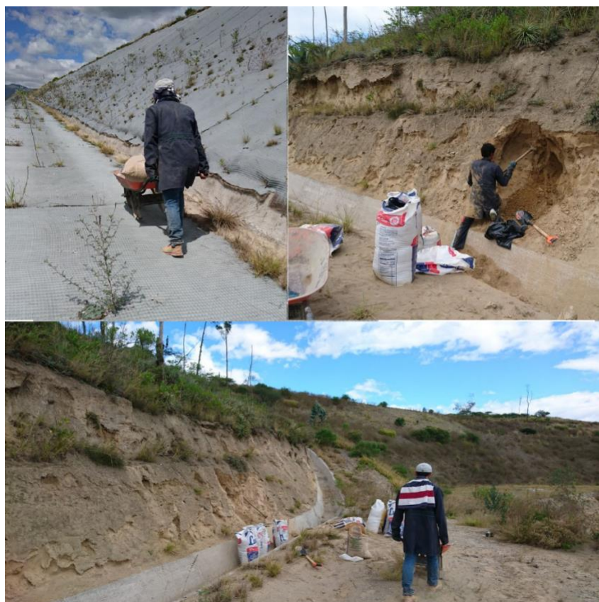
Figura 70 Extracción y movimiento manual del material SM
