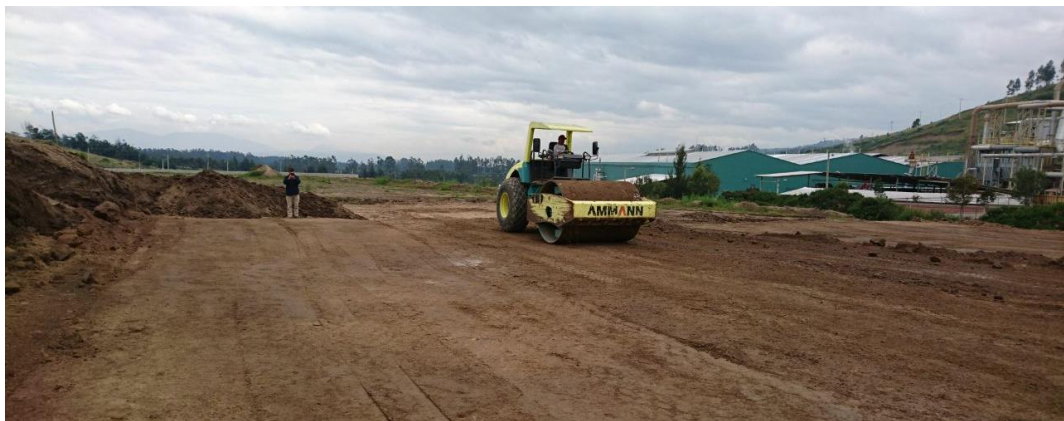
Figura 11 Aplicación de energía de compactación
