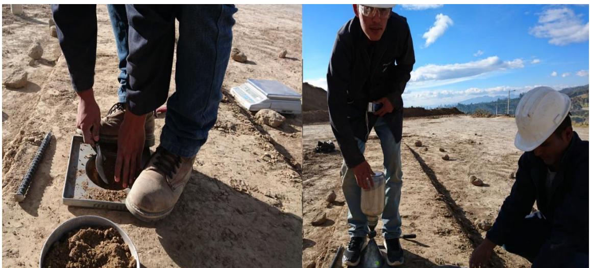
Figura 76 Control de compactación cono y arena
