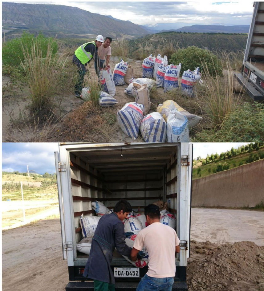
Figura 71 Transporte y descarga del material SM
