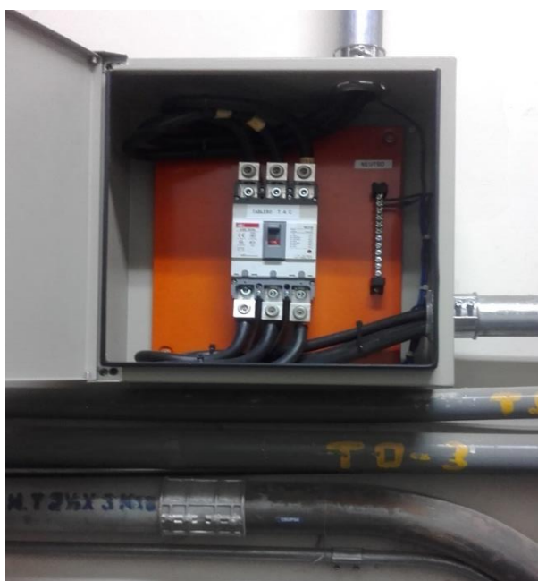
Figura 64. Punto de medición Tomografía TAC.
