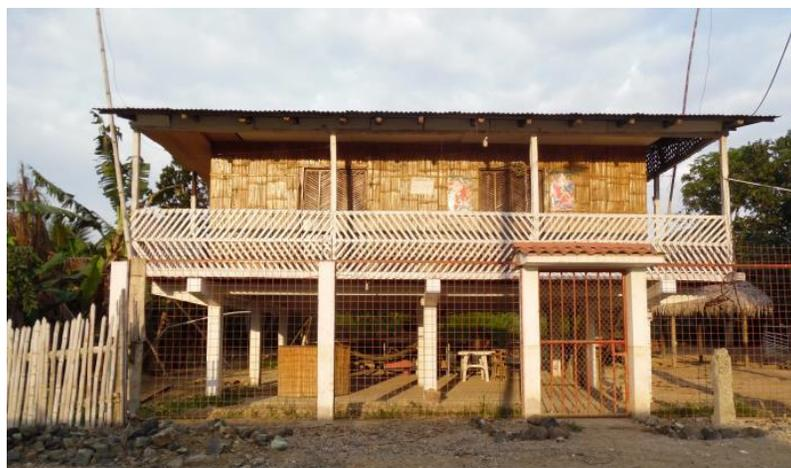
**Figura 87.** Casa de caña con subestructura de hormigón armado para la cimentación y columnas en Estancia vieja.
