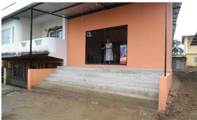
**Figura 86.** Casa de hormigón y bloque elevado a 1m sobre el nivel de vía en Estancia vieja.
