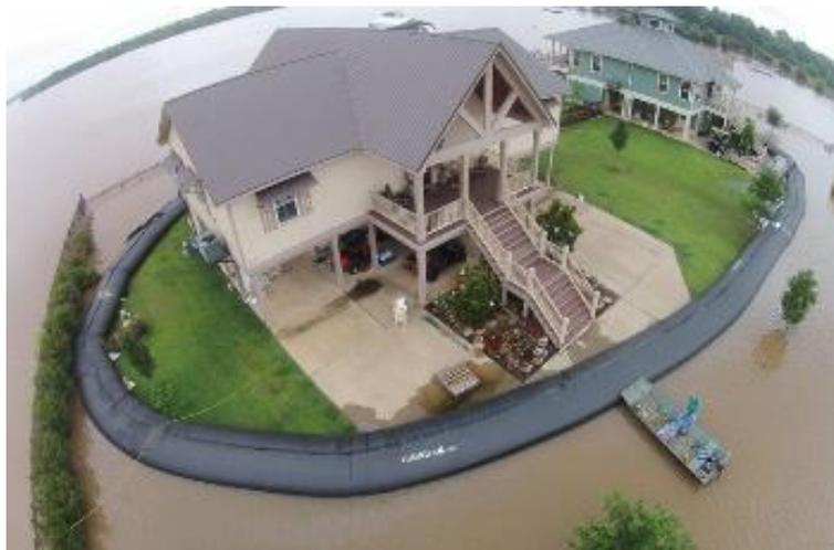
**Figura 89.** Sistema de protección con tubos de polietileno para proteger la vivienda ante la inundación.
