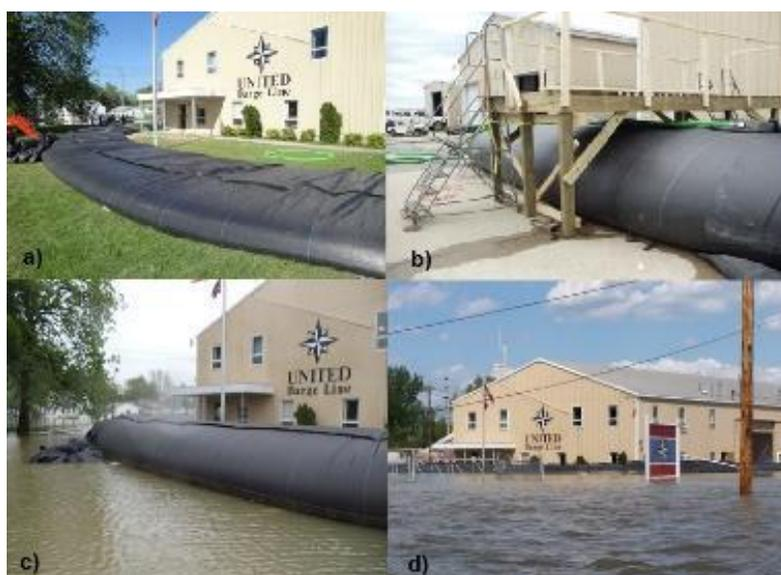
**Figura 90.** Instalación del AquaDam para la protección de un edificio de las inundaciones del río Ohio en Metropolis, Illinois.
