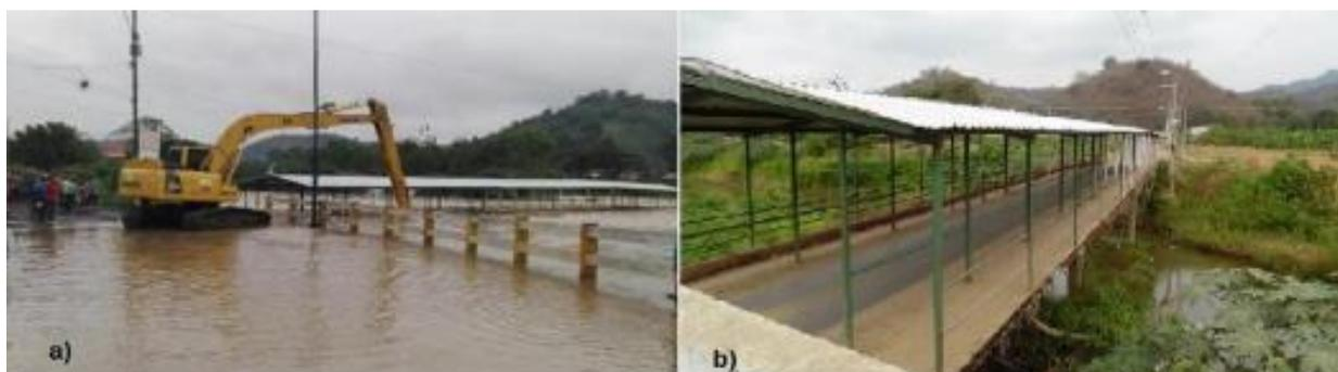
**Figura 49.** a) Río Portoviejo alcanza el nivel del puente peatonal durante la precipitación de 74,4 mm que se dio el día 8 de abril del 2017. b) Estado normal del río tomada el día 18 de diciembre
