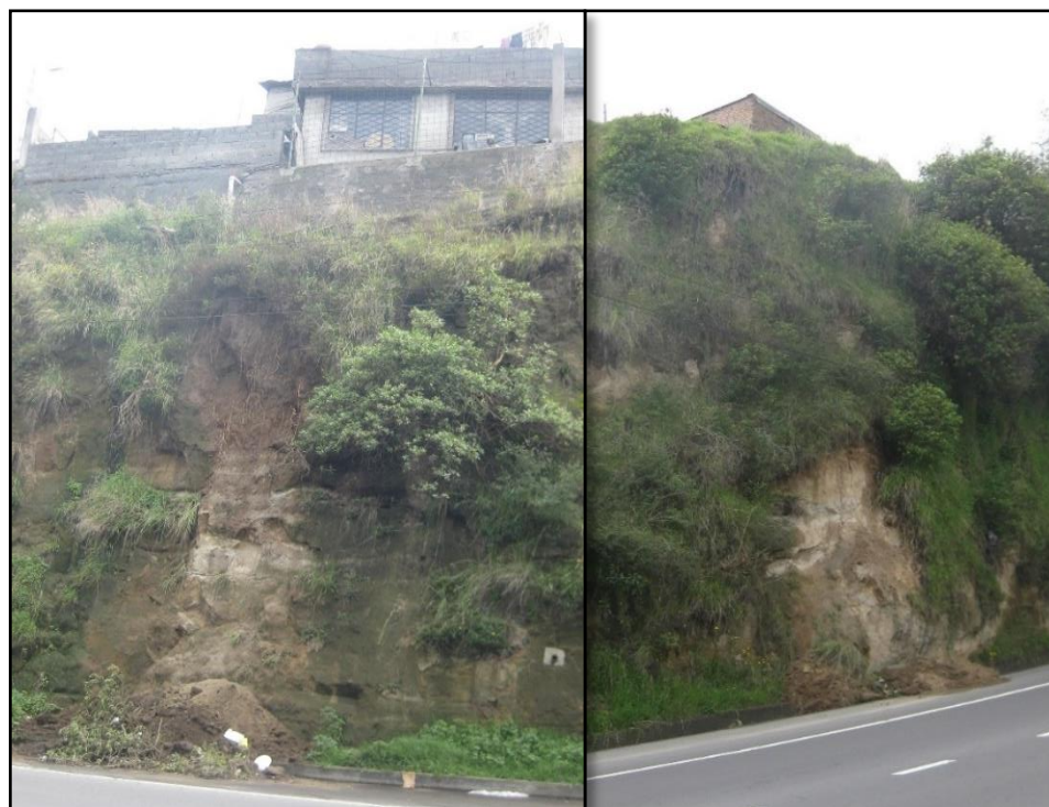
Figura 22. Vista del talud en el sector de Monjas Tramo I
