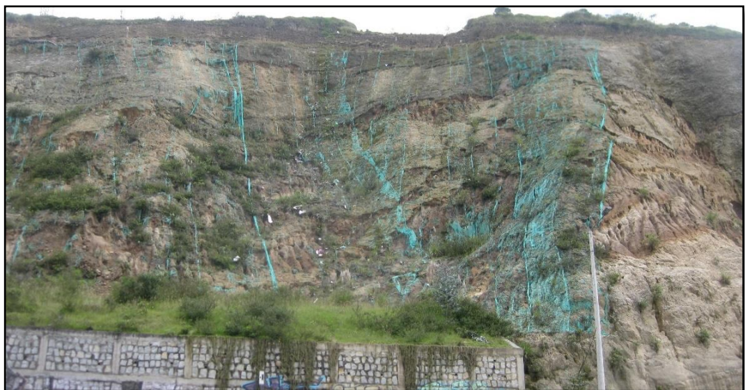
Figura 16. Vista del talud en el sector de la Forestal Tramo I
