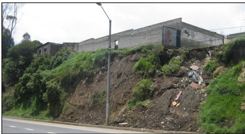
Figura 20. Vista del talud en el sector de la Forestal Tramo III
