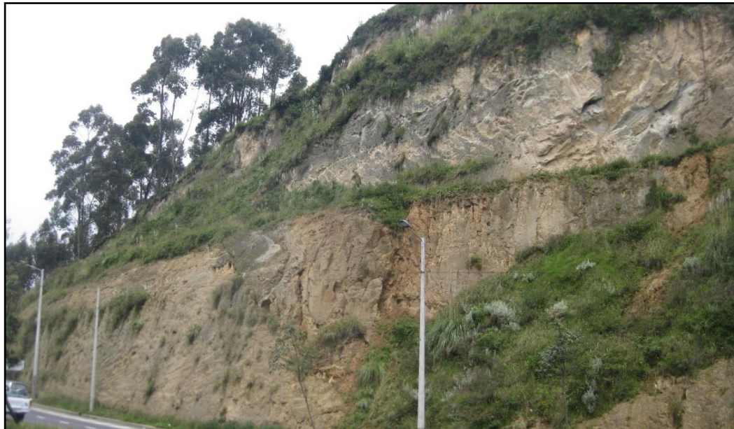
Figura 18. Vista del talud en el sector de la Forestal Tramo II
