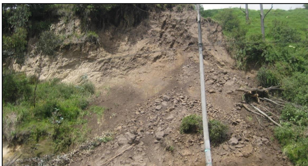
Figura 24. Vista del talud en el sector de Monjas Tramo II
