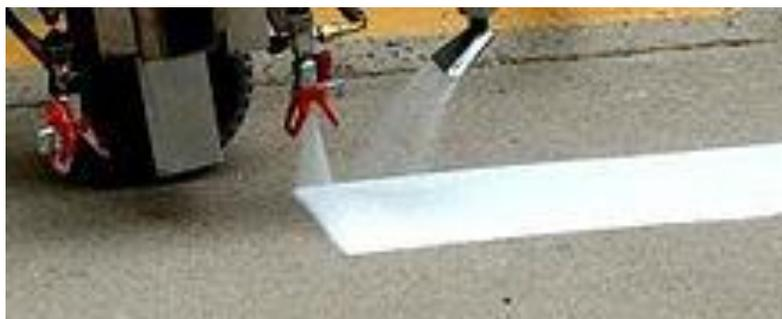
**Figura 56.** Colocación de Microesferas de vidrio y pintura de tráfico
