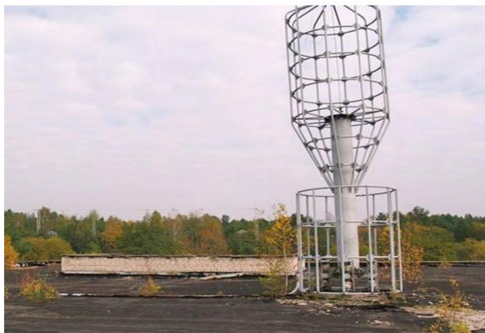
Figura. 3. Arreglo de antenas de Wullenweber Fuente: (Stalker Krug, 2014).
