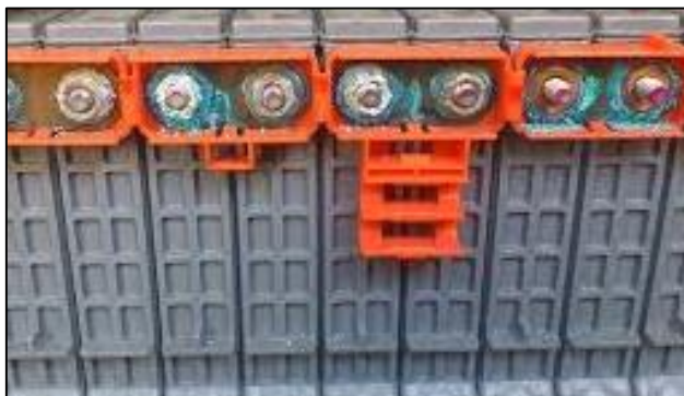
Figura 90: Bornes sulfatados
