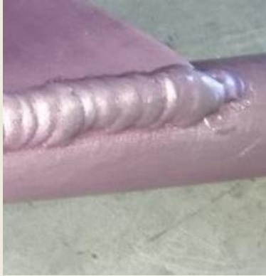
Limpieza e inspección visual
