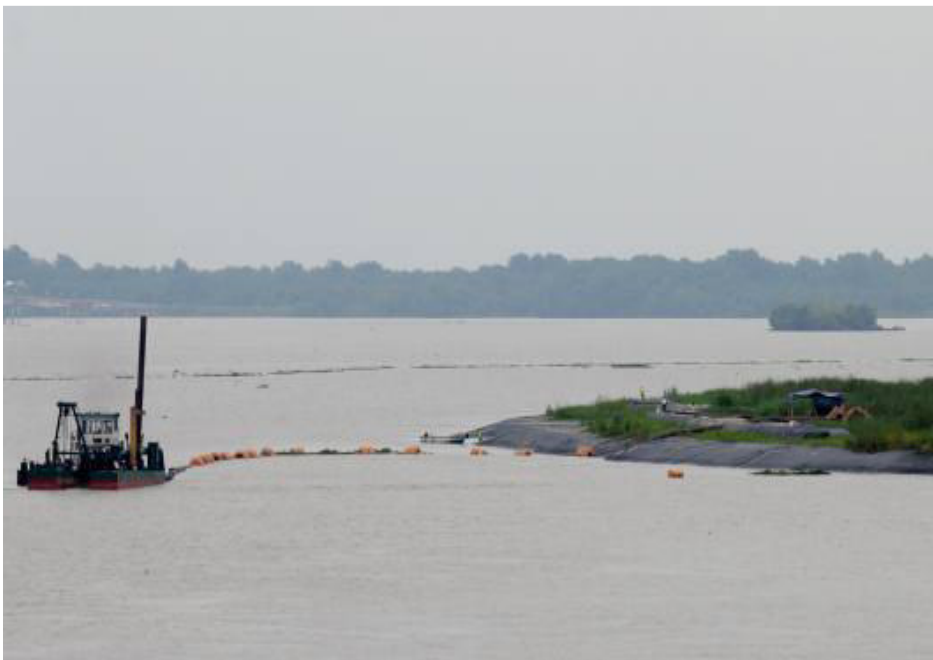
Figura 8 Ejecución de dragado
