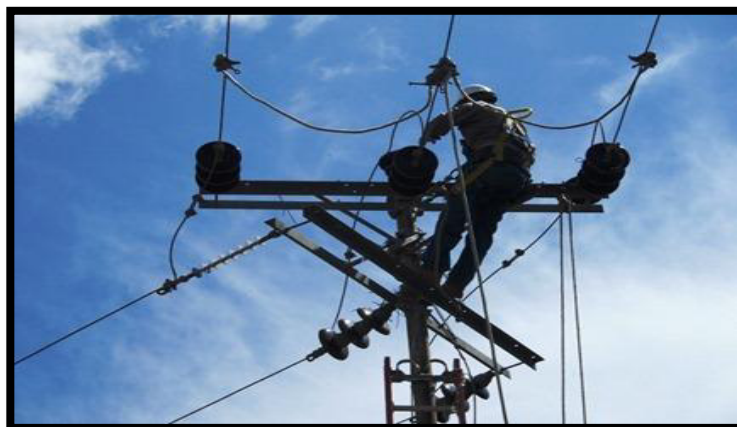
Figura 2.8: MANTENIMIENTO ELÉCTRICO CORRECTIVO Fuente: http://www.leanoticias.com/
