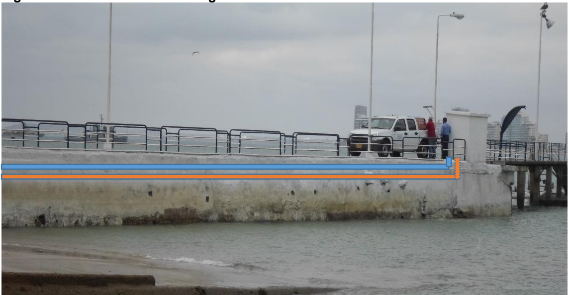
Figura 4-4. Ubicación de las mangueras hasta el final del muelle
