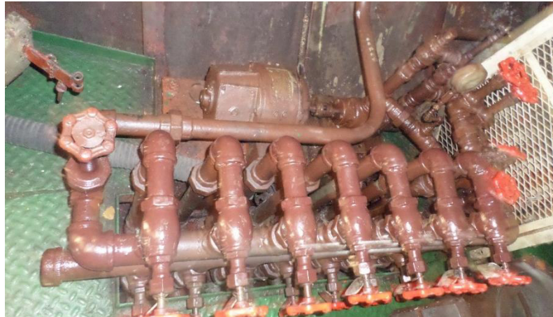
Figura. 2.3 Sistema de combustible
