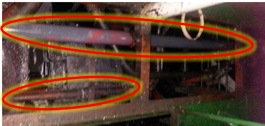
Figura. 4.2 Vista real de una tubería trabajada y sin trabajar
