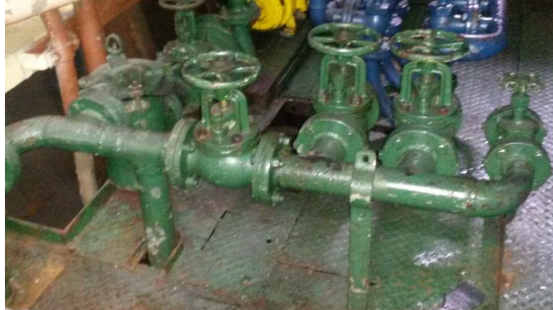
Figura. 2.4 Sistema de achique
