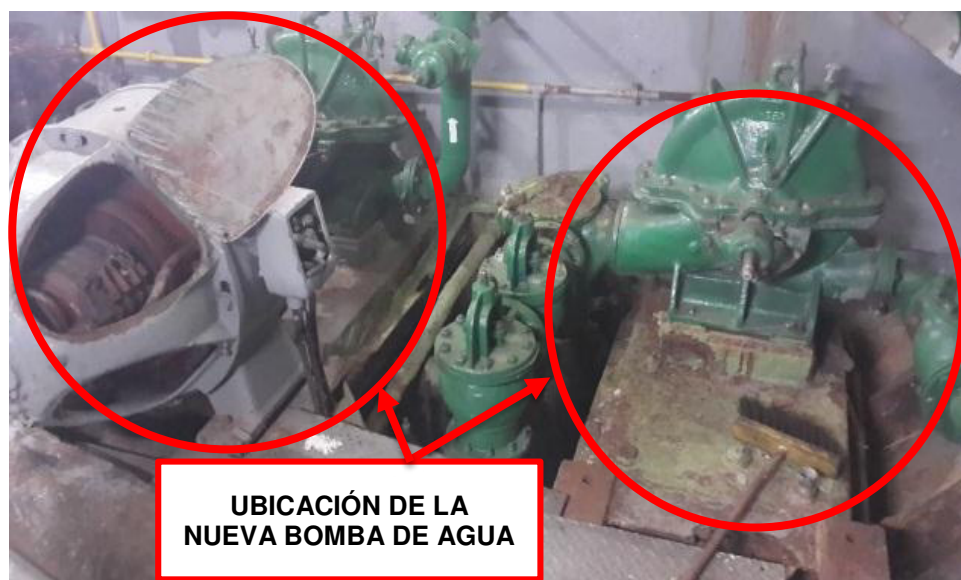
Figura 4.1 Fotografía de la ubicación de Bomba de salvataje P500 por bomba de agua nueva
