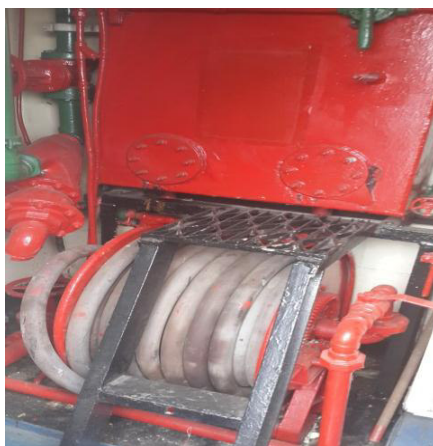
Figura 3.16 Fotografía de los banco de foam Fuente y elaborado por: Andrés Idrovo González
