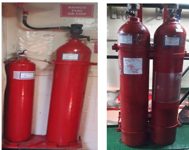
Figura 3.13 Fotografía de los bancos fijos de CO2 Fuente y elaborado por: Andrés Idrovo González
