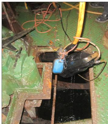
**Figura 2.17.** Bomba sumergible en la sentina
