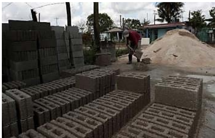
Figura 20. Elaboración manual de bloques huecos de hormigón
