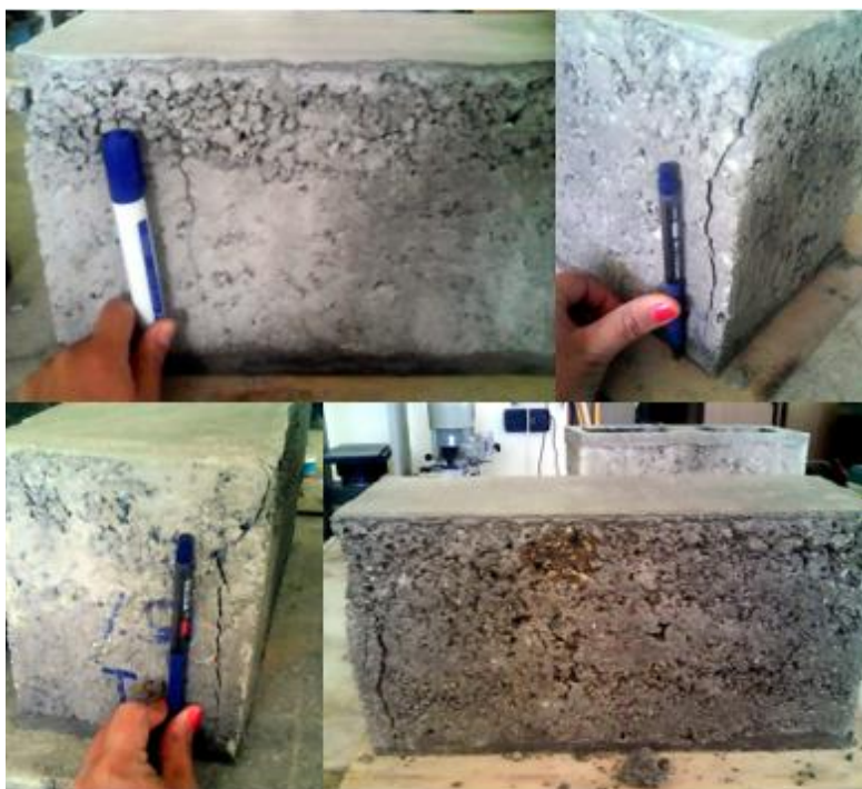
Figura 47. Fisuras producidas en bloques huecos de hormigón con 25% de PET en reemplazo y sin nanoaditivo, sometidos a cargas de compresión
