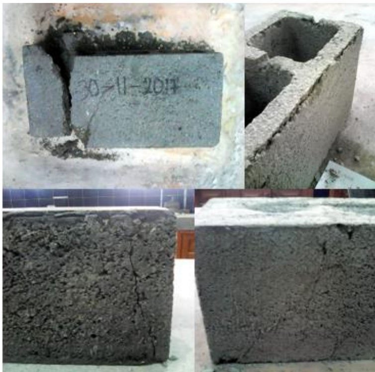
Figura 39. Fisuras producidas en bloques de hormigón sometidos a cargas de compresión
