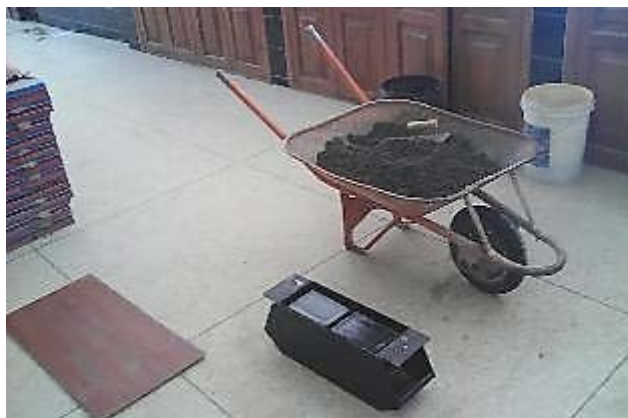
Figura 26. Hormigón seco utilizado en la elaboración de bloques huecos
