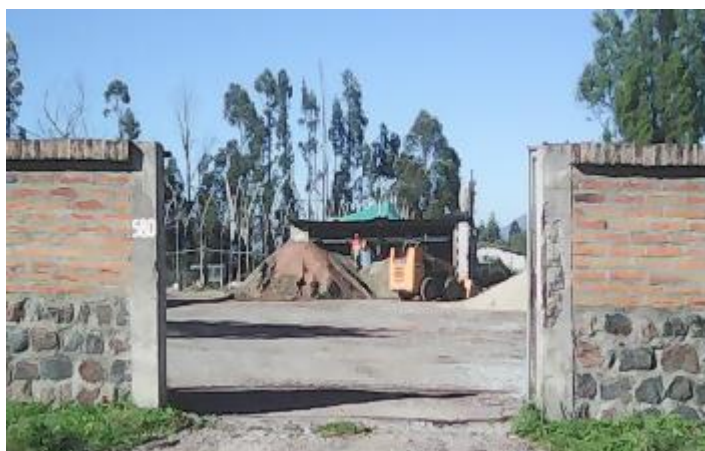
Figura 5. Bloquera Alan Service ubicada en el Barrio Santa Teresa-Sangolquí
