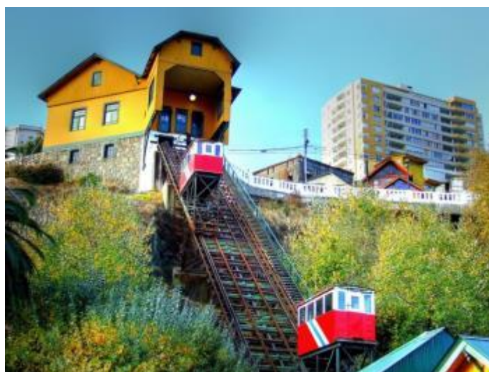
Figura 50. Ascensores eléctricos de Valparaíso.
