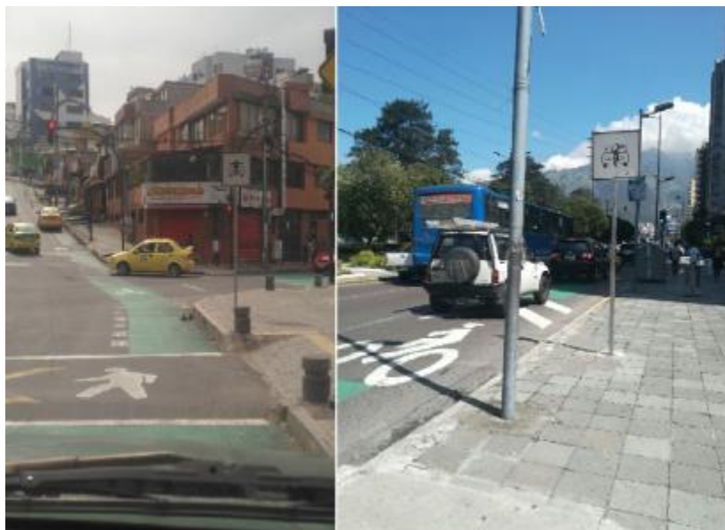
Figura 116. Carril segregado Tipo I.
