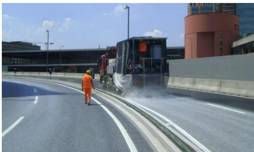
Figura 13. Aplicación de producto fotocatalítico sobre calzada
