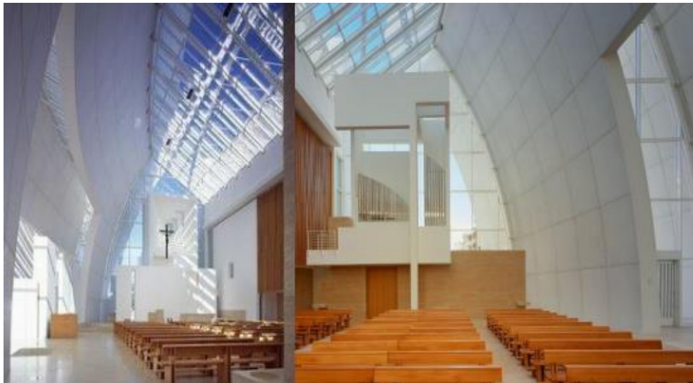
Figura 15. Parte interior de la Iglesia construida con cemento fotocatalítico
