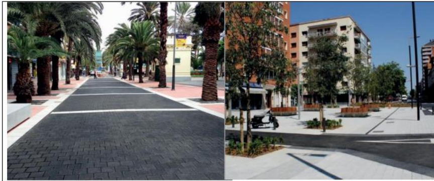
Figura 12. Pavimento discontinuo con efecto fotocatalítico
