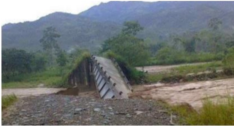
Figura 58 Puente sobre el Río Maravilla-Babahoyo. Fuente: (El Telégrafo, 2015)
