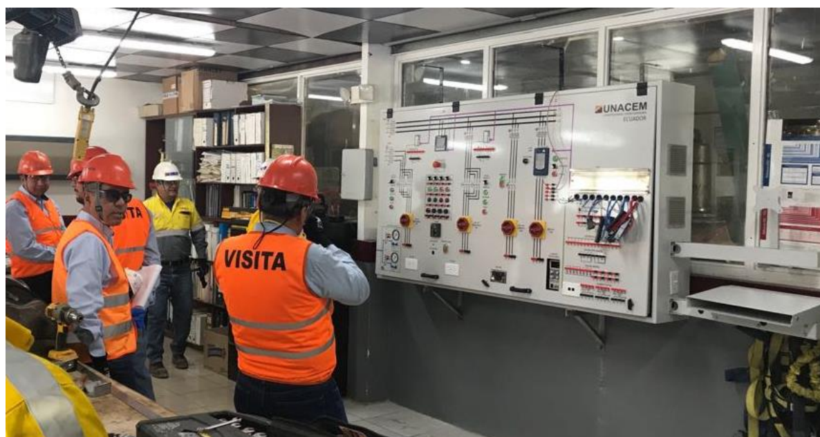
Figura 88. Montaje en sitio Sistema de Entrenamiento
