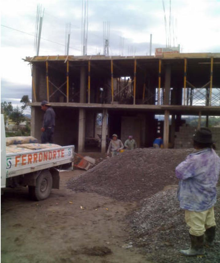
*Equipos Instalados para la fundición de losa de hormigón armado en Otavalo.*
