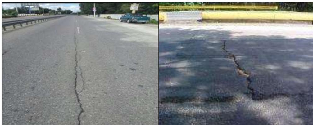
**Figura 2** Fisura longitudinal (izquierda), fisura transversal (derecha)
