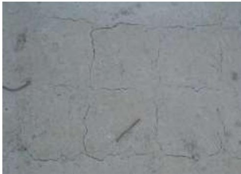
**Figura 6** Fisura de bloque
