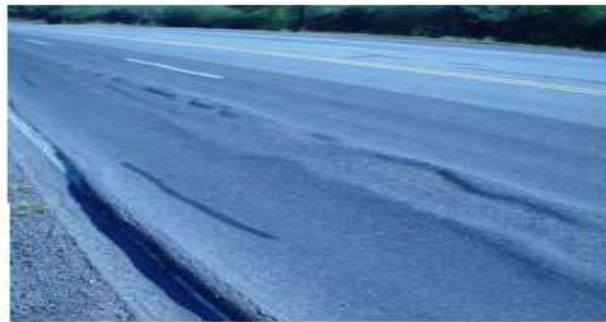
*Figura 17* Deformaciones permanentes
