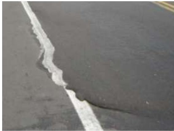
*Figura 8* Deformación de abultamiento
