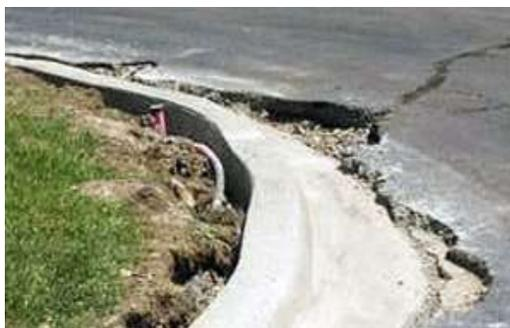
*Figura 5* Fisura de borde
