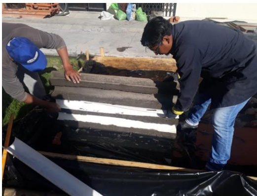
Figura 49. Retiro de tubería PVC
