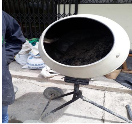
Figura 45. Elaboración de hormigón
