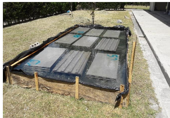
Figura 51. Curado de Paneles.
