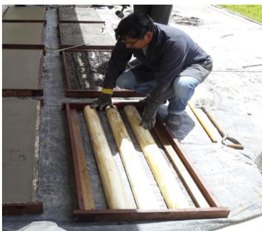
Figura 44. Encofrado de los paneles.
