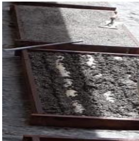
Figura 46. Fundición de paneles.
