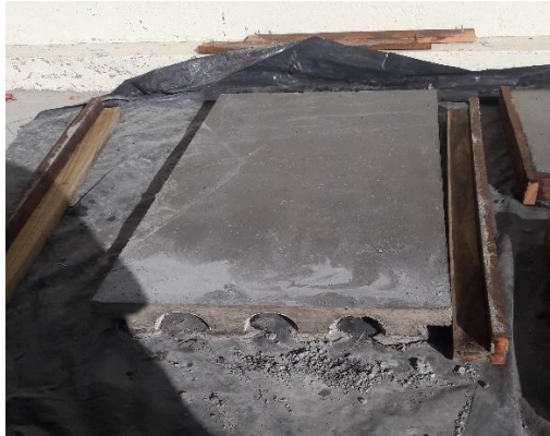
Figura 48. Desencofrado de paneles.
