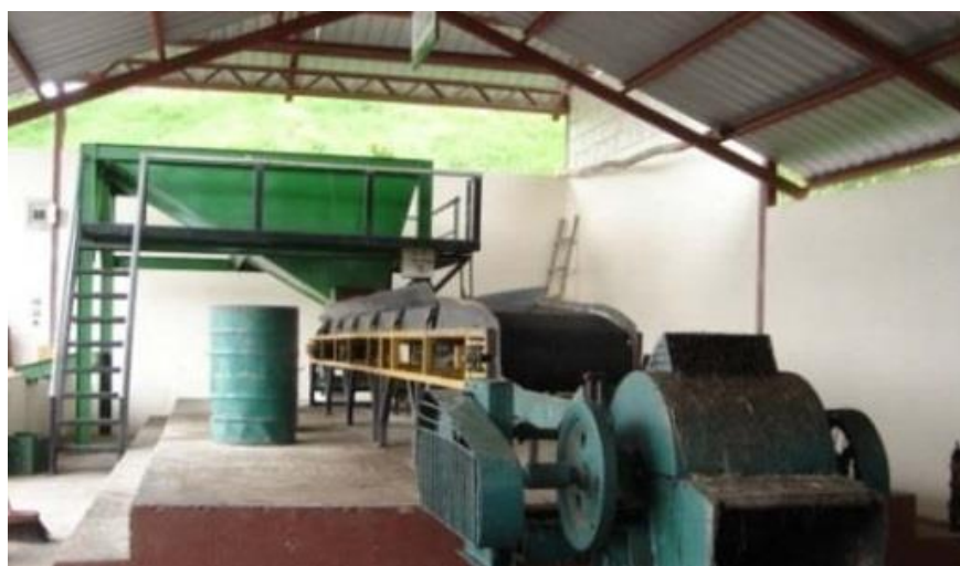
Figura 14 , Máquina de trituración de los residuos orgánicos gruesos.
