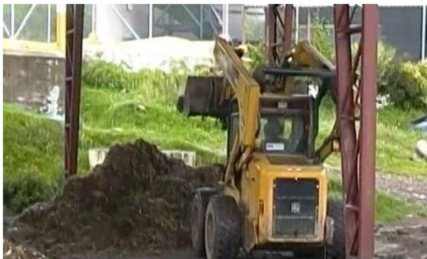
Figura 15, Uso de máquina Bob Cat para formar la Biopila.
