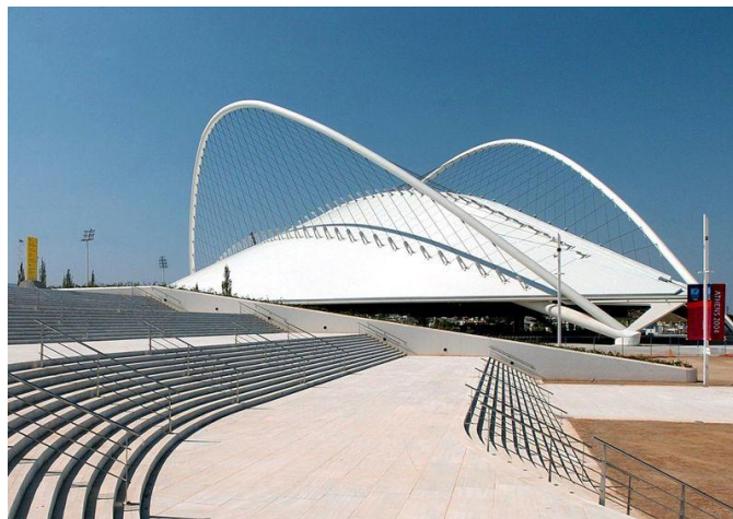
Fotografía 2.17: Arcos de una sola pieza, cubierta del Velódromo de Atenas.
