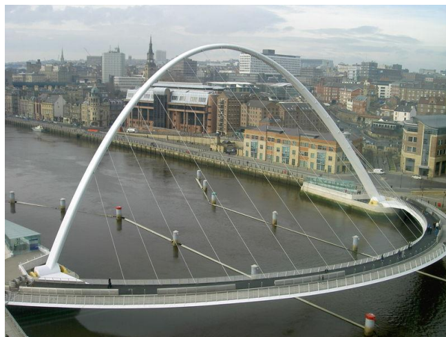
Fotografía 2.16: Arco portante del Puente del Milenio.
