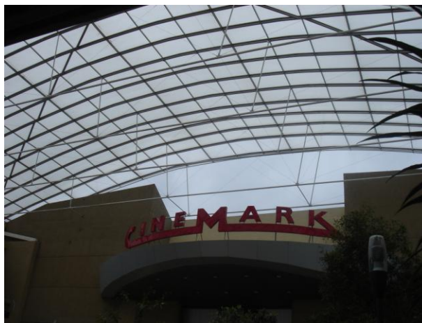
Fotografía 2.19: Cubierta de acero y cables del Cinemark en Quito.
