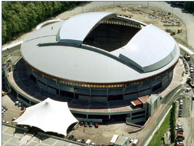
Fotografía 2.20: Cubierta mecanizada tipo parpado ubicada en España.
