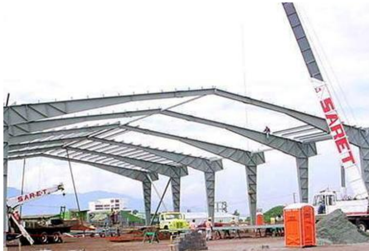
Fotografía 1.4: Utilización del acero estructural.
