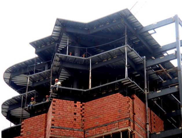
Fotografía 2.12: Clínica Internacional construida en estructura de acero.
