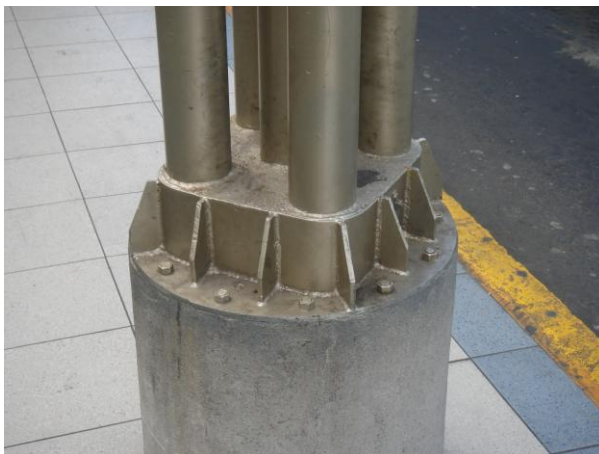
Fotografía 2.26: Anclaje de una columna de acero.
