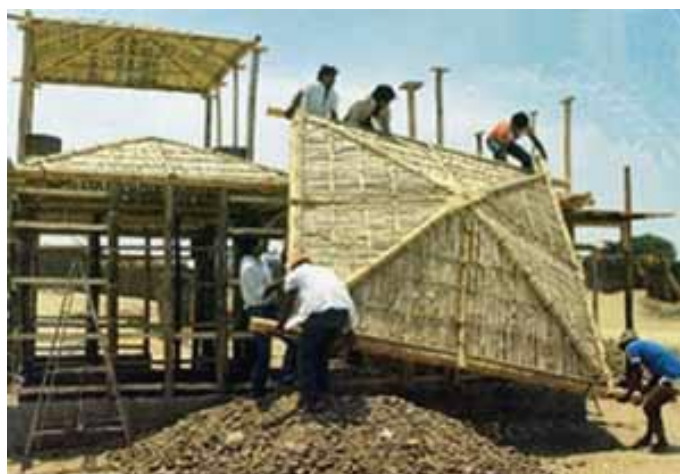
Fotografía 1.2: Cubiertas de caña.
