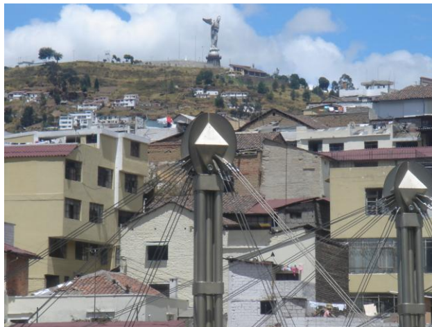
Fotografía 2.27: Anclaje de cables de acero.
