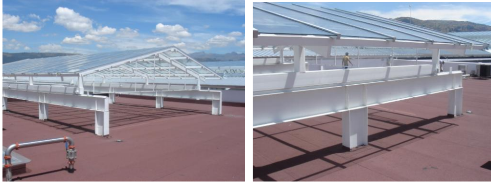
Fotografía 2.22: Estructura de la cubierta mecanizada del Mall “San Luís”.
