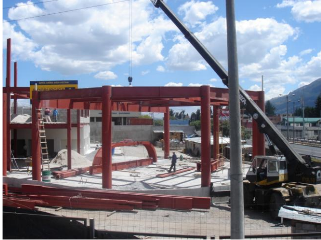
Fotografía 2.11: Estructura de acero pesada en el norte de Quito.
