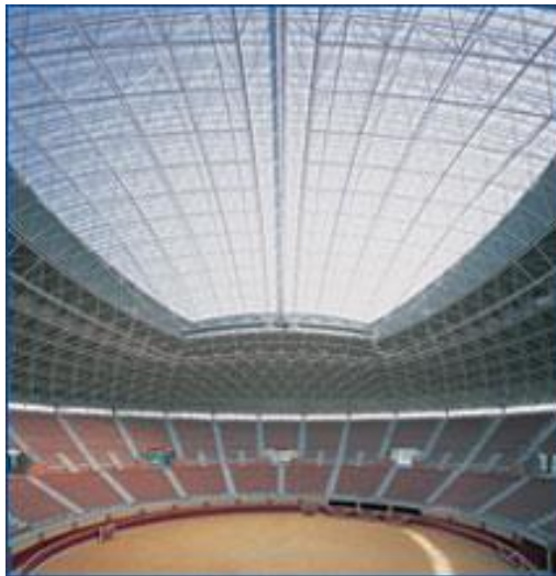
Fotografía 1.1: Cubierta de plaza de toros en España.
