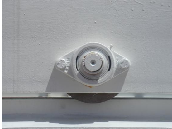
Fotografía 2.24: Rodamiento de la cubierta mecanizada del Mall “San Luís”.
