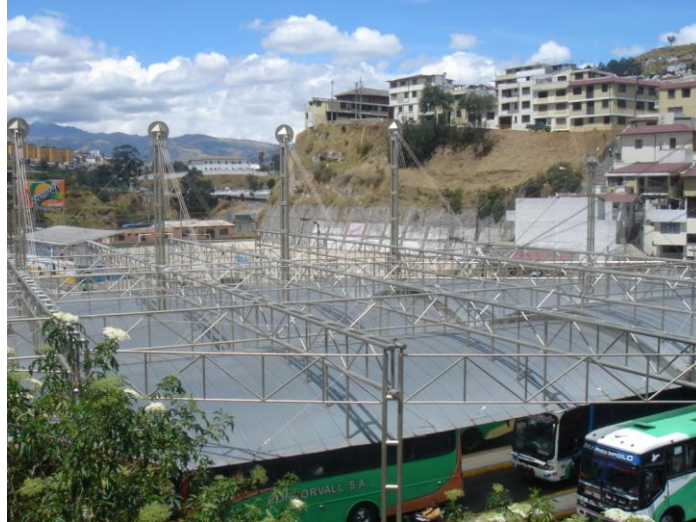
Fotografía 2.18: Cubierta con estructura de cables situada en la Marín.
