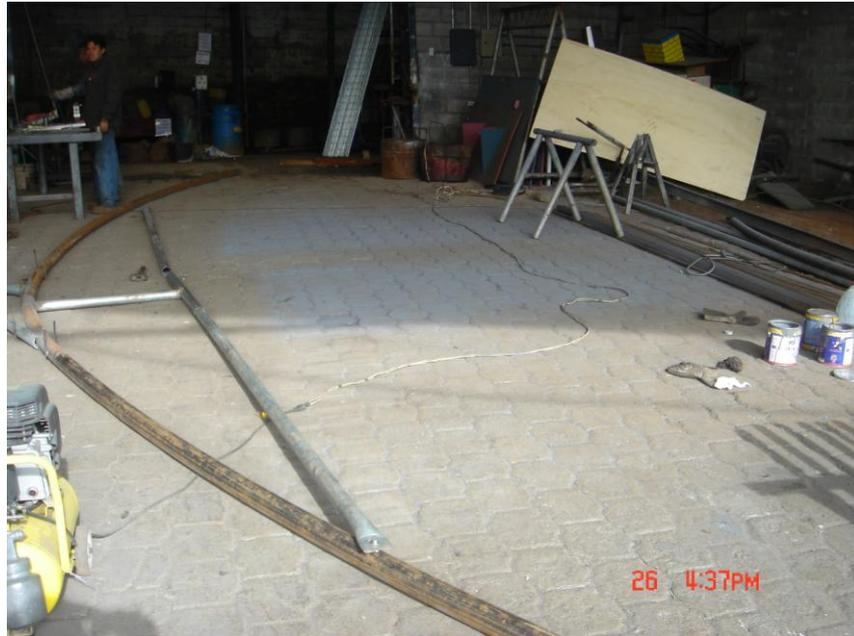
**Figura 5.29:** Cercha del hangar siendo ensamblada.
