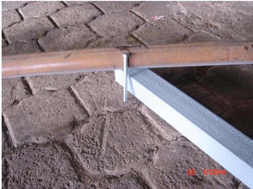
**Figura 5.33:** Unión de la columna a la cubierta.
