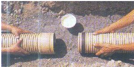
Fotografía N° 7.1.- Demostración de Sellantes
