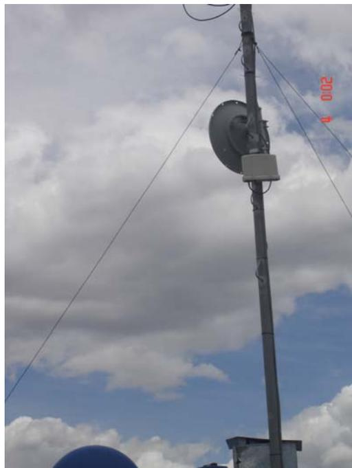
**Figura 4.48. Tubo de soporte de antena.**
