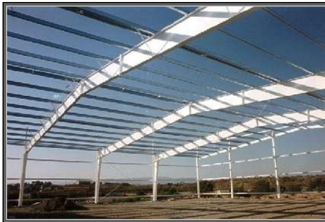
Figura 3.1: Nave armada con pórticos
