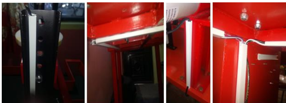
Figura 113. Aseguramiento de los cables a la estructura
