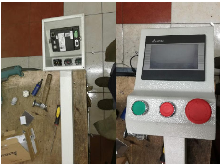
Figura 80. Montaje de la pantalla HMI y Botoneras en la estructura del panel de mando
