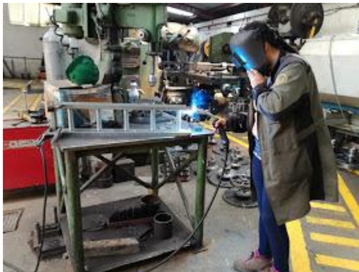
Figura 82. Construcción de la mesa con rodillos
