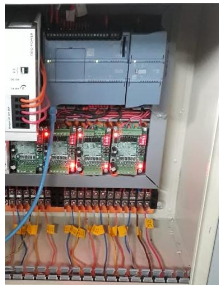
Figura 101. Energizado de Tablero
