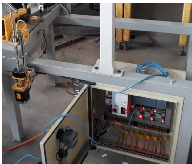
Figura 97. Motor del ascenso y descenso de la cierra
